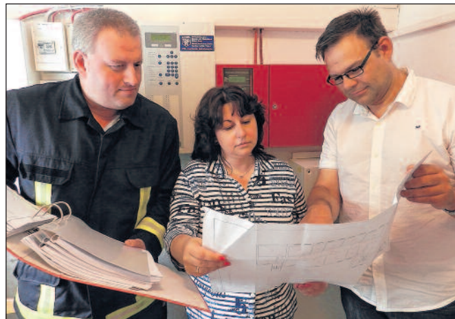
Ziehen gemeinsam an einem Strang – Gemeindeführer Henning Tröger, Sozialbetreuerin Anna Papageli und Einrichtungsleiter Karsten Brückner vor der Brandmeldeanlage im Asylbewerberheim Werdau
