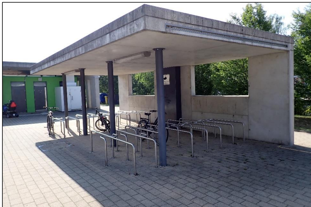
Abbildung 6: Radabstellanlage mit geeigneten Anlehnbügeln; überdacht, beleuchtet und mit Videoüberwachung (Bahnhof Meerane, Quelle: ISUP 2024)
