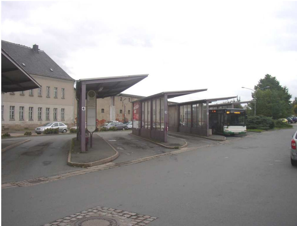
Abbildung 7: Verknüpfungshaltestelle Bus/ Schiene „Bahnhof“ in Werdau (Stand 2006)
